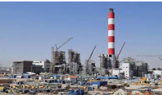
56 Khabat Termik Santrali Projesi Ünite 1 & 2
