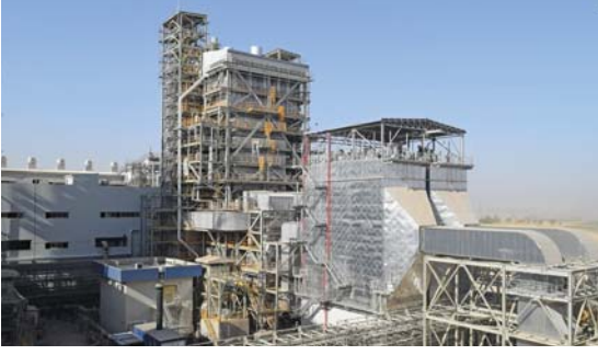
42 Khabat Termik Santrali Projesi Ünite 1 & 2
